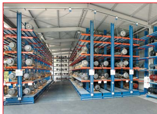
Im überdachten Hofbereich im Stammwerk bewegen vier verfahrbare Wagen die neue, dynamische Kragarmregalanlage mit einer Länge von 24 Metern.
